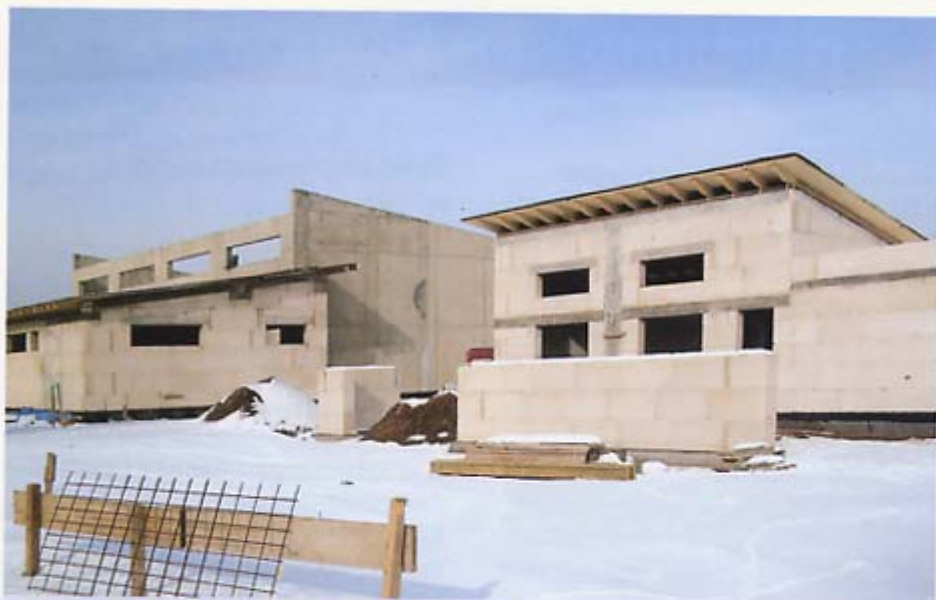
Turnhalle (links) und Verwaltungsstrakt (rechts)
