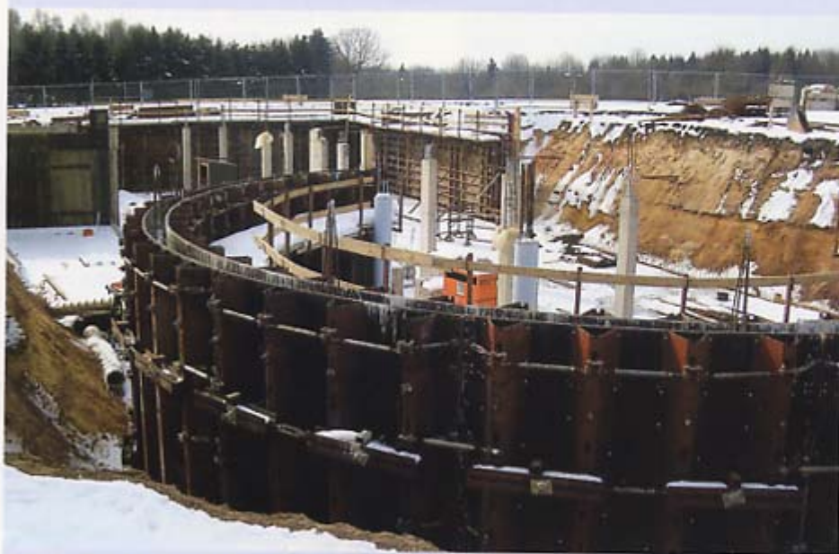
Blick auf die Entstehung des Wellness-Gebäudes
