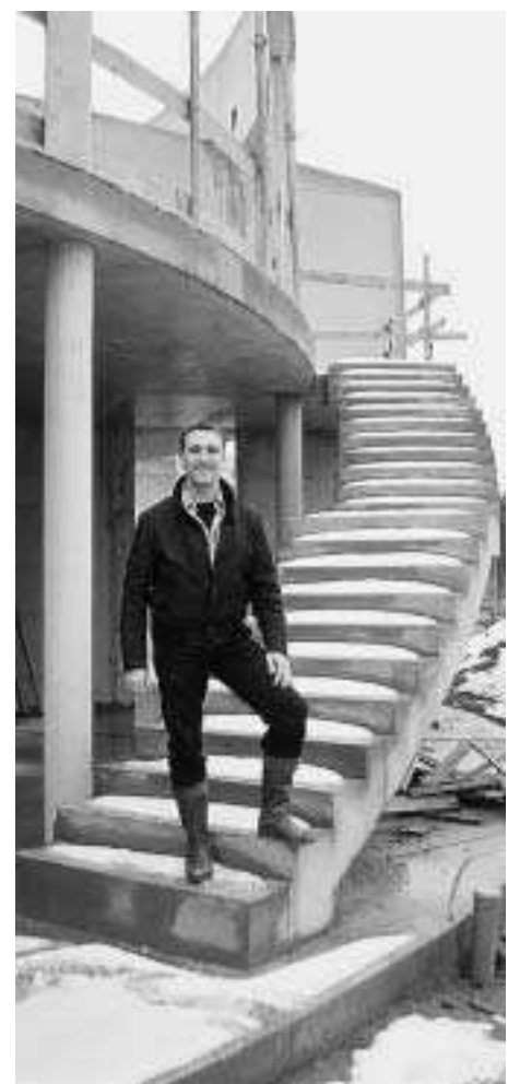
Diese Treppe führt später hinauf in die Eventhalle.
