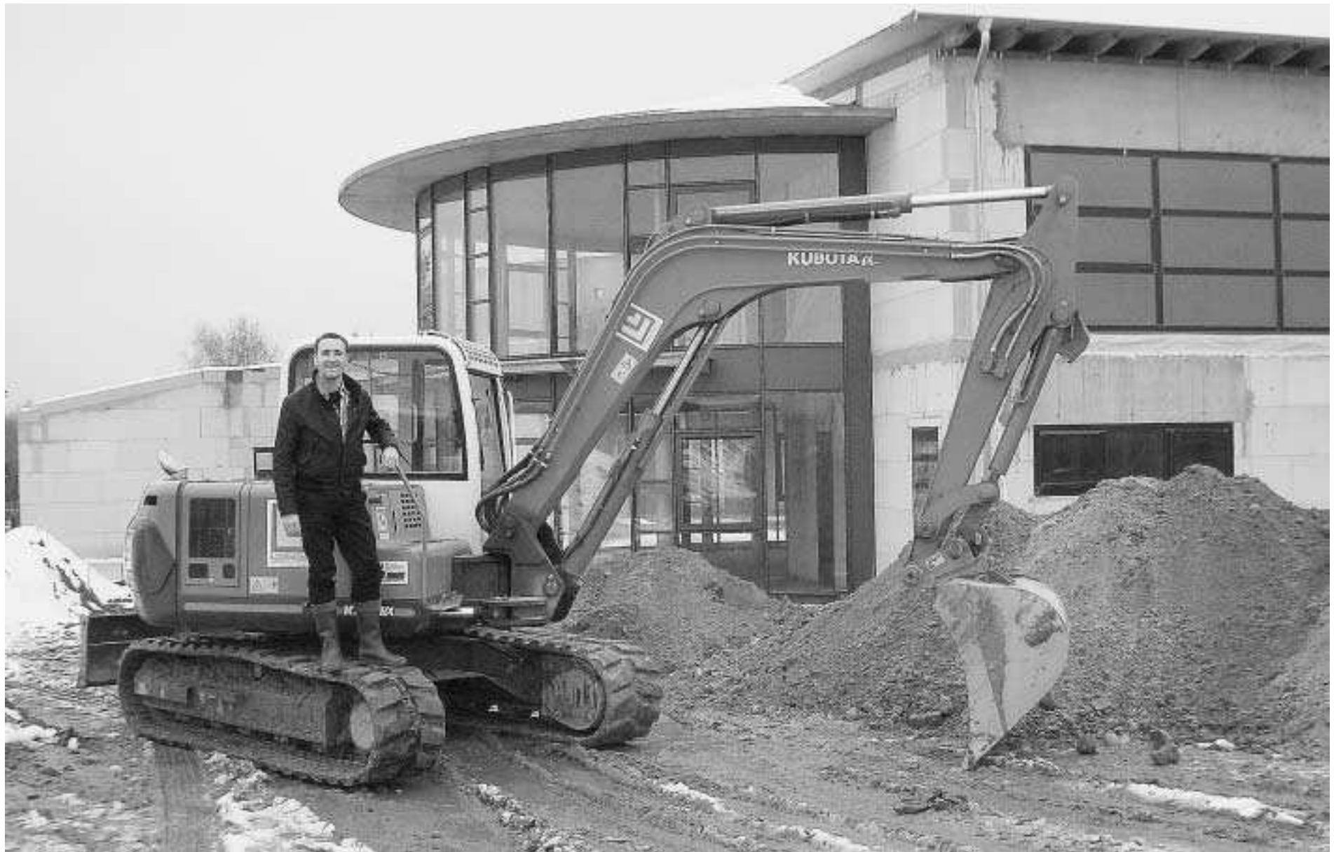
Michael Krauss auf „seiner“ Baustelle: Hier entsteht das Centrum für Freizeit und Kommunikation in Spiesen.
